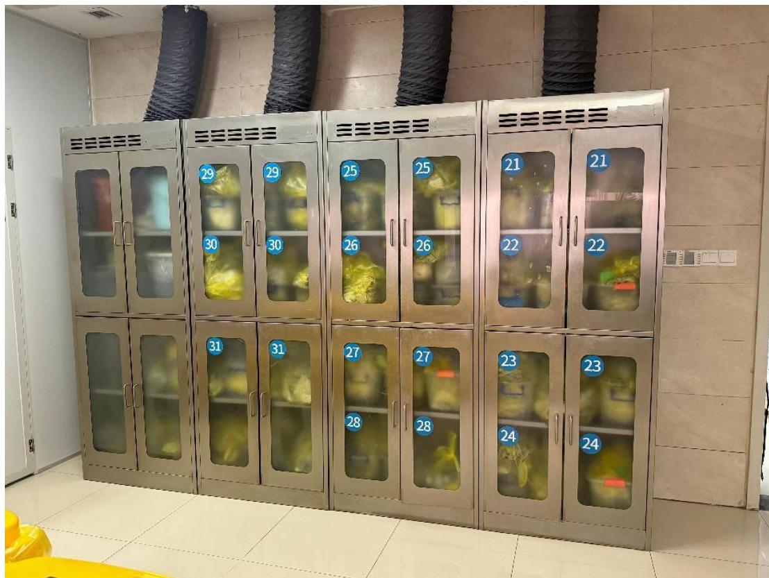
病理科病理性废物暂存柜
